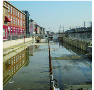
Aanleg spoortunnel in 2012
